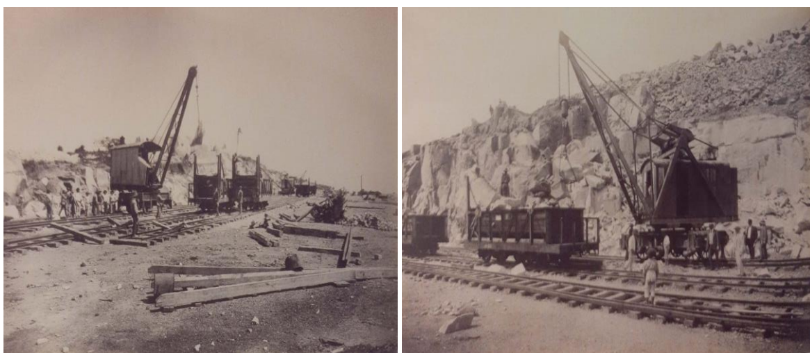
Figura 2: Pedreiras localizadas no interior de Pelotas destinadas para a construção dos Molhes da Barra de Rio Grande. Fonte: Santos [2020].
